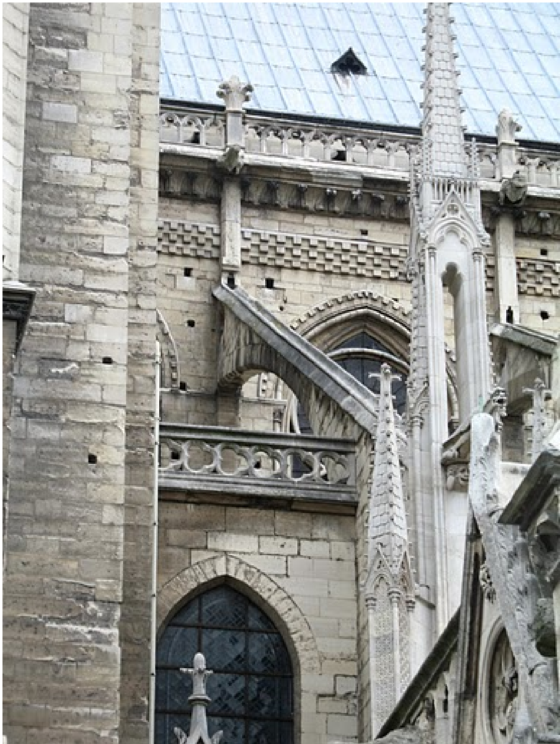
Chéneaux en pierre plus que contreforts
